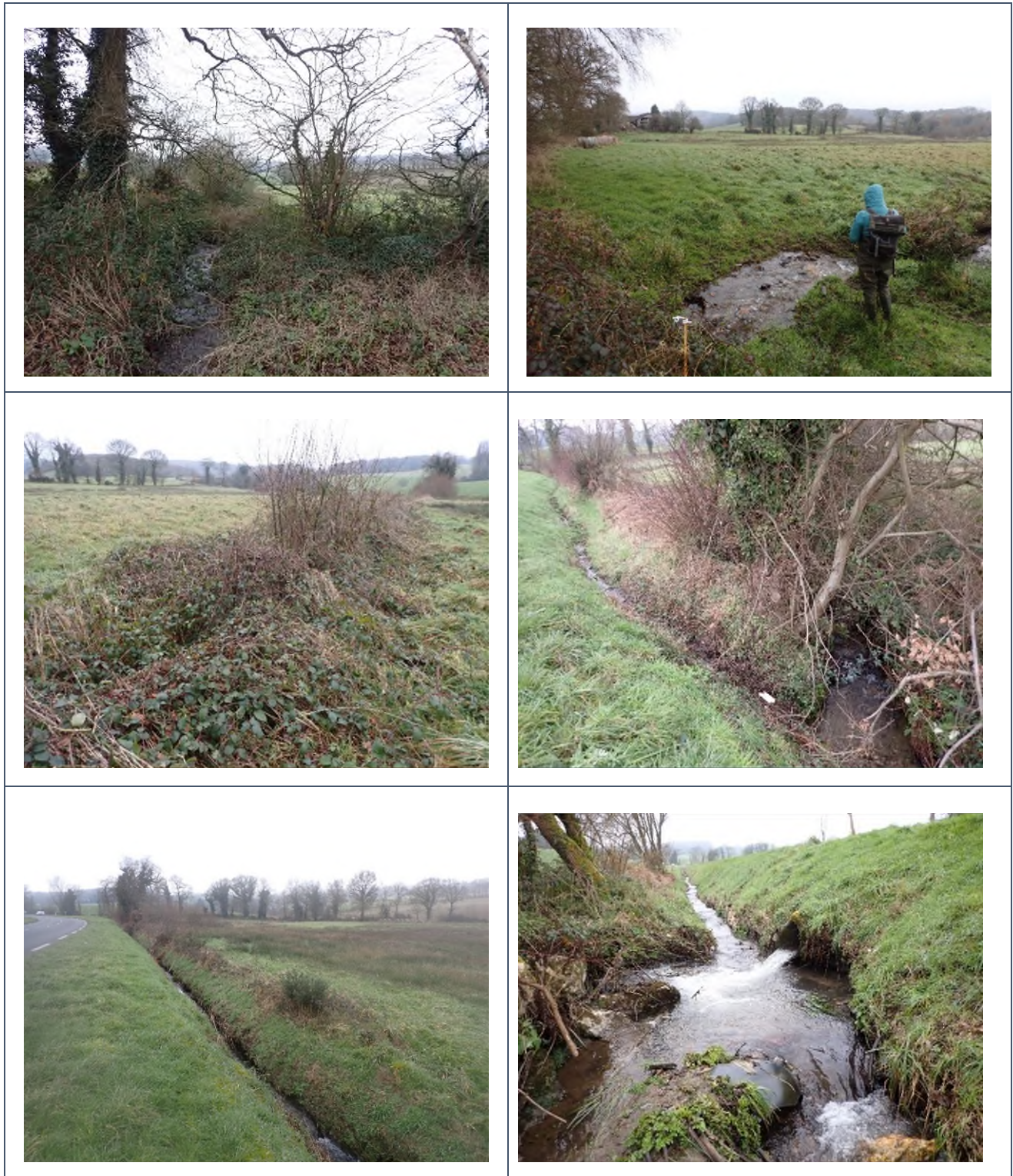
Figure 13 : Photographies du Tarabust d'amont en aval (de haut en bas) (Fish-Pass)
