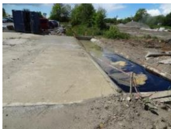
Photographie 3 : Exemple de bassin de stockage de produits polluants, d'aire de lavage de goulotte de toupies et d'aire de lavage d'engins équipée en sortie d'un débourbeur-déshuileur (© Egis / D. Ferreira)
