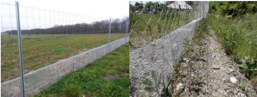
Figure 178 : Exemple de clôtures à mailles fines 6 mm x 6 mm (© Egis)
