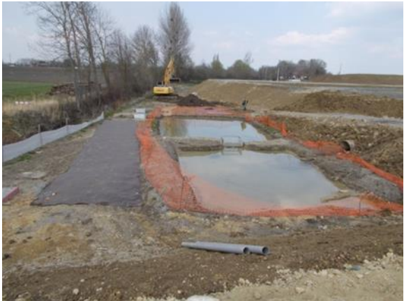
Figure 152 : Exemple de dispositifs d'assainissement provisoire mis en place en phase travaux (© Egis / D. Ferreira)
