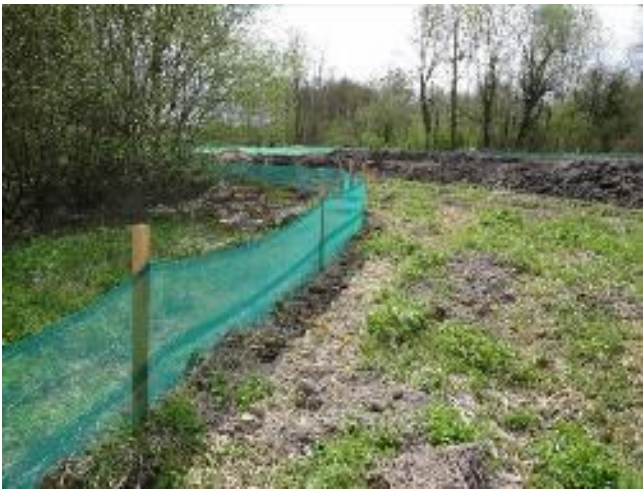
Photographie 5 : Exemple de fixation de bavolet et barrières anti-intrusion posées
