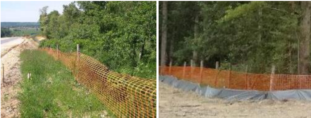
Photographie 4 : Barrière-type de délimitation d'emprise de chantier
