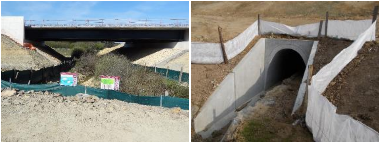
Photographie 1 Exemple de protection de cours d'eau par clôtures géotextile sous un ouvrage de type cadre ouvert avec préservation de la végétation rivulaire et principe
