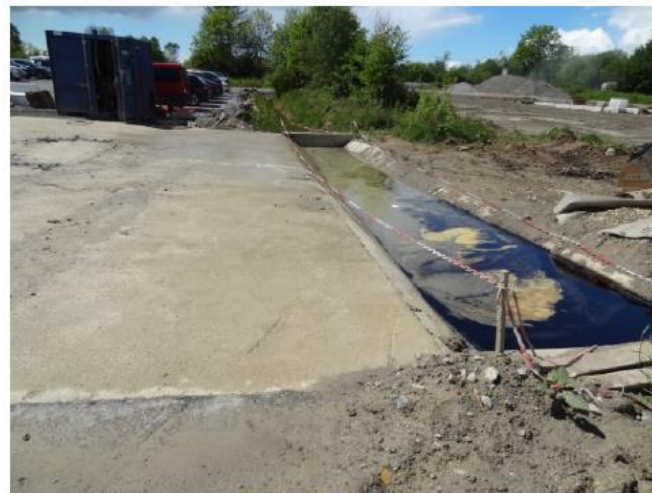
Figure 153 : Exemple de bassin de stockage de produits polluants, d'aire de lavage de goulotte de toupies et d'aire de lavage d'engins équipée en sortie d'un débourbeur-déshuileur (© Egis / D. Ferreira)
